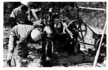
宮沢地内で行われた地質調査
