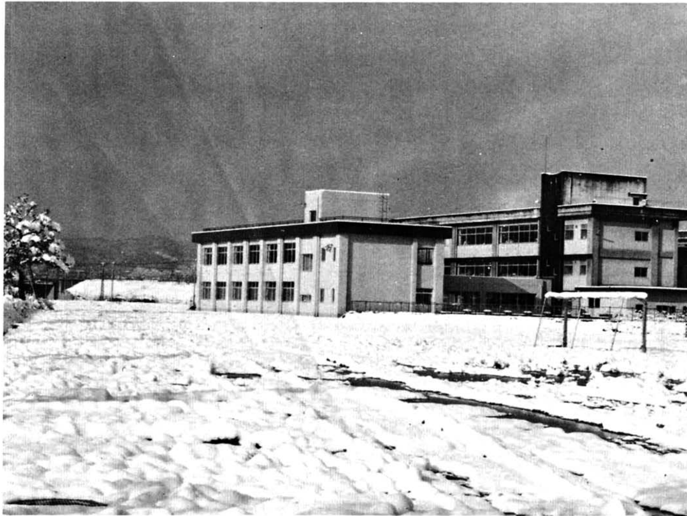
越路小学校に教室棟鉄筋コンクリート2階建6教室が増築され、12月13日竣工式が挙行された。
