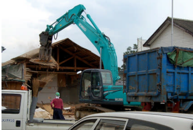
解体の様子 撮影日 8月18日 玄関付近
