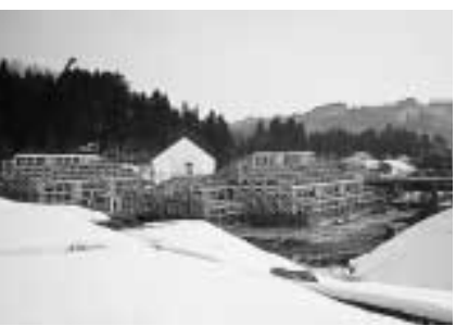
平成16年4月開校に向けて建設が進む越路西小学校
