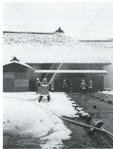
▲長谷川邸内で消火訓練
