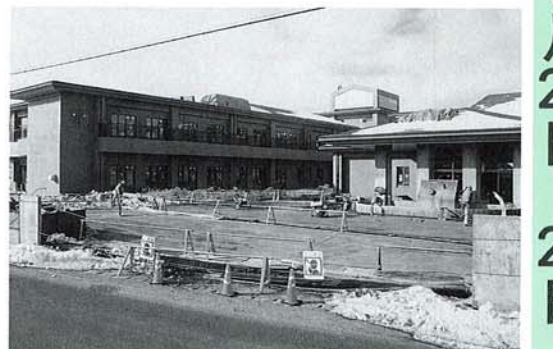
完成間近いわらび園
