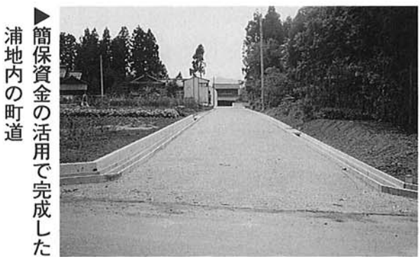
簡保資金の活用で完成した浦地内の町道
