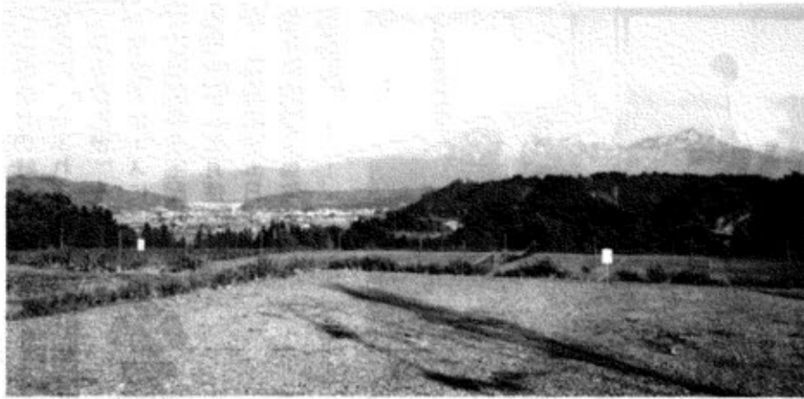
▲自然に抱かれた「スポーツとロマンのファミリー高原」リゾート一大基地の建設が着々と進む。
