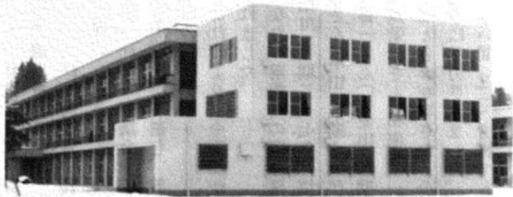
▲完成した川口中食堂棟
