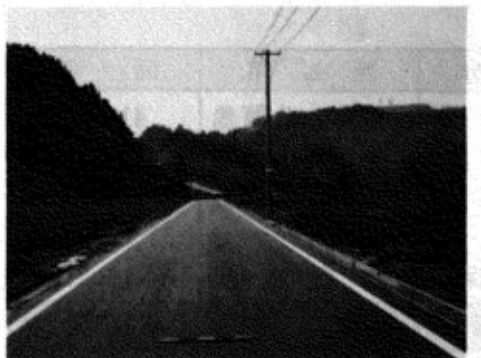
▲西倉農村基盤総合整備 桑巻農道
