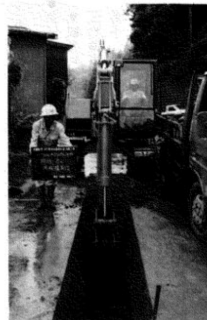
▲61年度(最終年度)配水管布設工事が行われ、中央簡易水道が完成しました。
