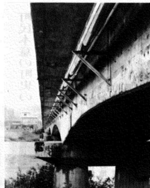
▲川口橋の下に架設された 水道管（鋼管φ150%L=211m） 工事は約3ヶ月を要した。
