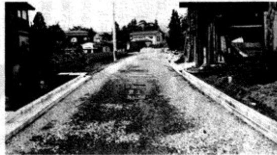
▲ 昭和57年度改良された町道（牛ヶ島地内）
