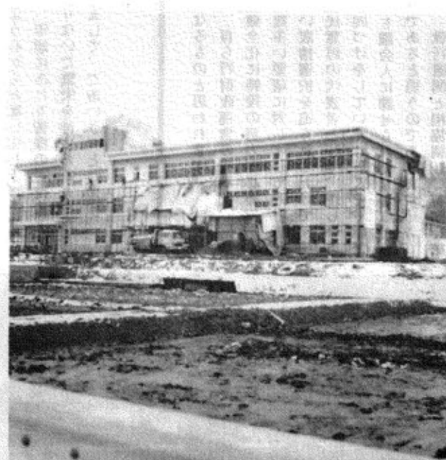
▲新制度により入札され順調に進む建築工事 (57.12.27撮影)
