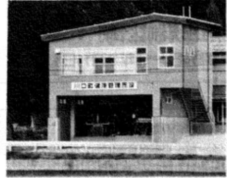
完成された管理施設
