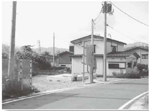
東川口克雪ポンプ場
