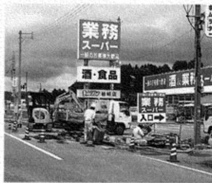
水道復旧工事
