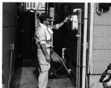
ガス閉栓作業
