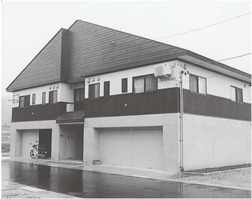
り災者公営住宅 (田麦山)
