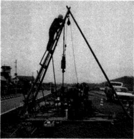
▶地質調査ボーリング
