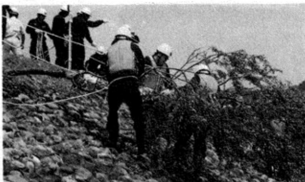
▶木流し工（川口町消防団） 洪水により堤防が洗掘されたり、洗掘されそうな場合に流水の勢いを減じ、法崩れを防ぐ工法
