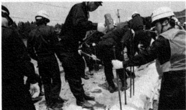
▶積み土のう工（小千谷市消防団） 洪水により堤防が沈下したり、増水により水が堤防を越えそうな時に、堤防天端に土のうを互い違いに積み上げ、越水を防ぐ工法
