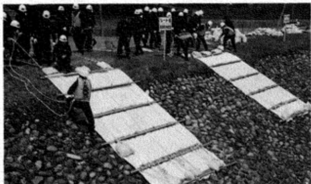
▶水のうマット工（建設省班） 積み土のう工と同様に水が堤防を越えそうな時に、堤防天端に水のうを置き、越水を防ぐ工法
