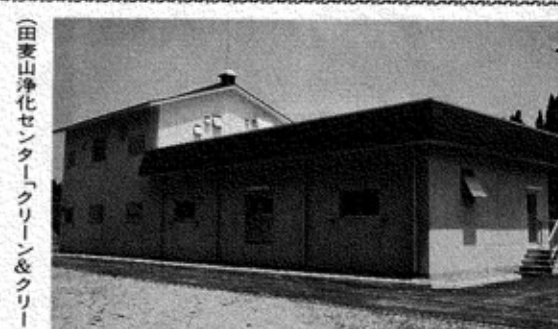
▲「水質の保全、居住環境の改善に」田麦山地区農業集落排水事業
