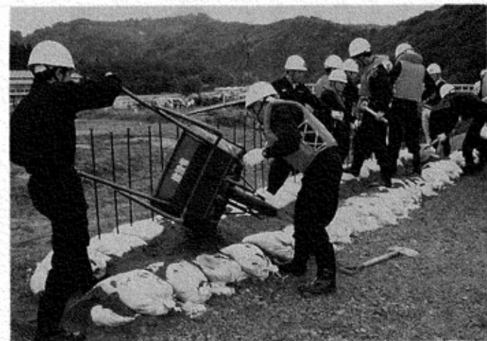
▲積み土のう工(川口町消防団) 洪水により堤防が沈下したり、増水により水が堤防を越えそうな時に、堤防天端に土のうを互い違いに積み上げ、越水を防ぐ工法
