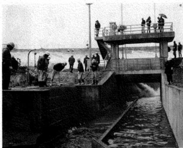
▲完成した水門と吸水槽(左岸)
